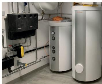
Splitanlage mit Wärmepumpe
