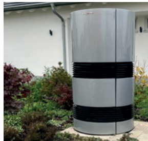
Wärmepumpenheizung
