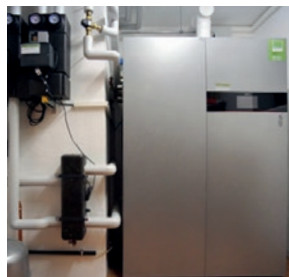
Brennstoffzellenheizung
